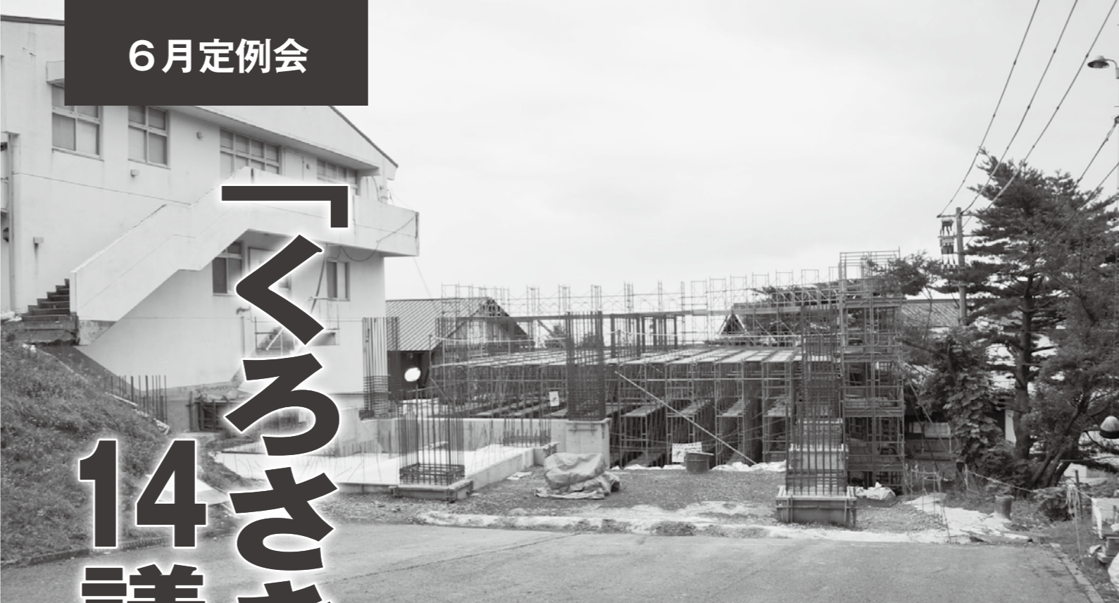
厨房・食堂部分が改築され、チップボイラーが設置される「くろさき荘」(8月11日)
