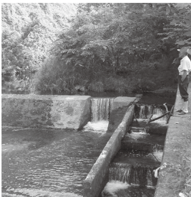
普代川の上流域にある上普代頭首工。鮭の遡上などを考えて作られています
