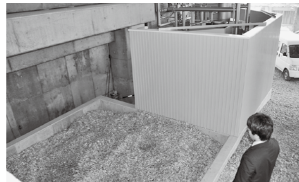
くろさき荘に設置されたチップボイラー
