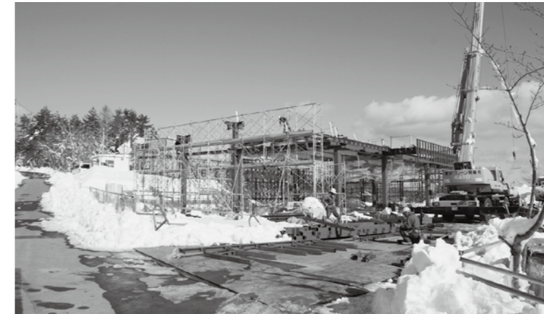
鉄骨工事が行われている給食センター（1月22日）
