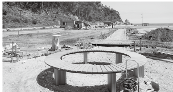
芝張り工事が行われる普代浜園地の北側地区
