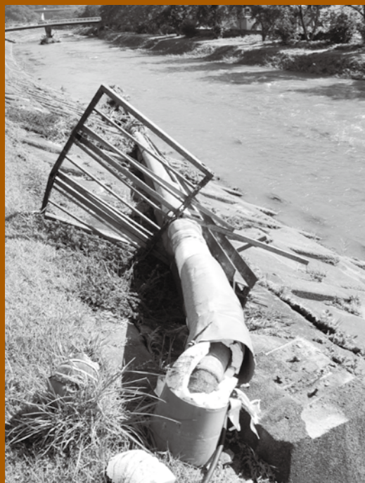
普代簡易水道の水管橋(配送水管)が根元から折れ、普代元村は3日間断水。多くの人が飲み水を求めた
