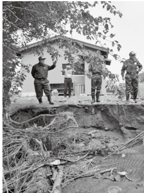
台風10号で越水した普代川（沢山橋の上流）
