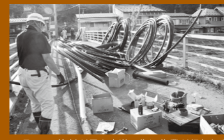
9月1日、資材が届き水道の復旧作業が行われた
