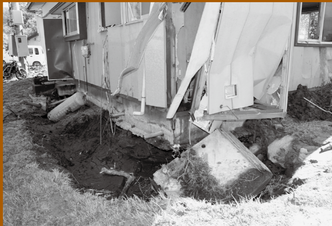
濁流の勢いで壁が壊され基礎部分がむき出しになった上区地内の住宅
