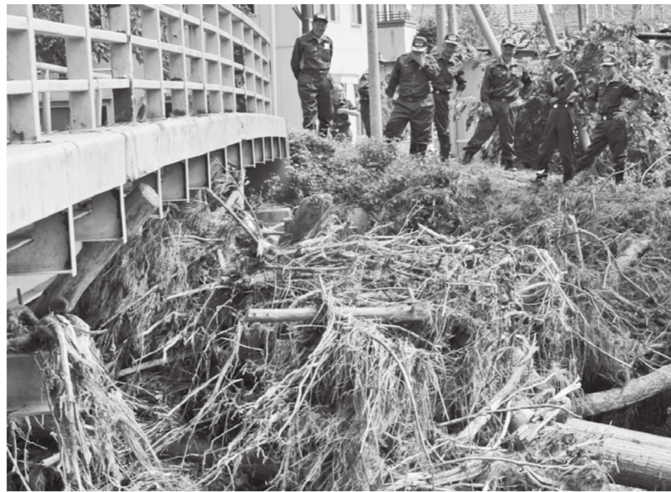
被害状況を視察する議員（上区の羅賀橋に詰まった流木）
