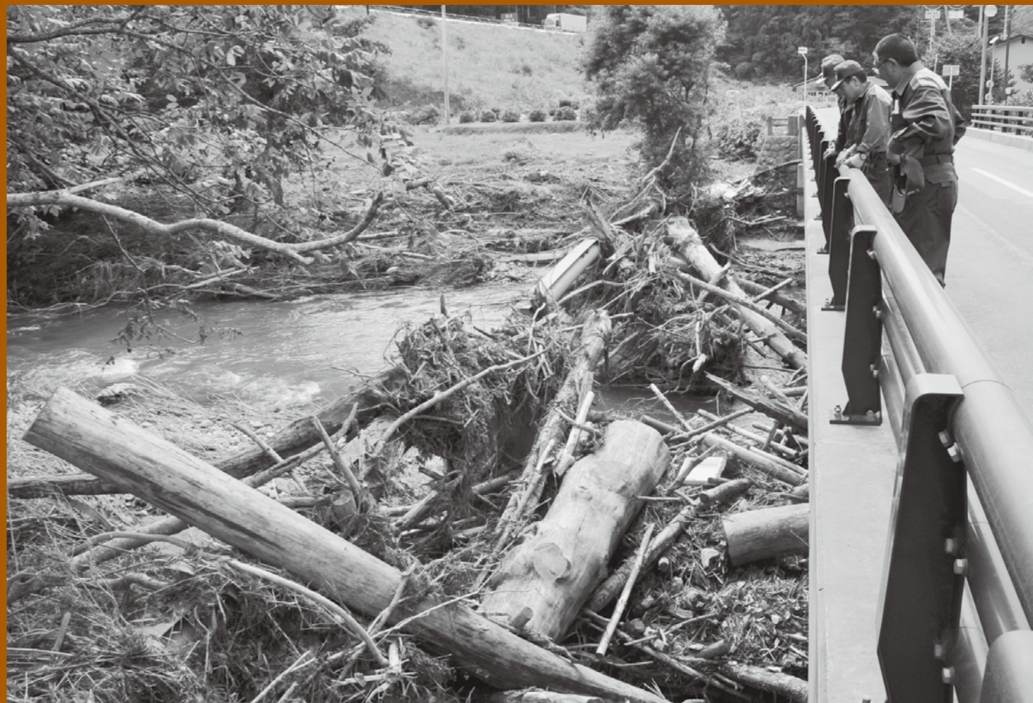
上普代・深渡橋の下流に詰まった大量の流木。橋の左右から道路、住宅に大量の濁流が流れ込んだ
