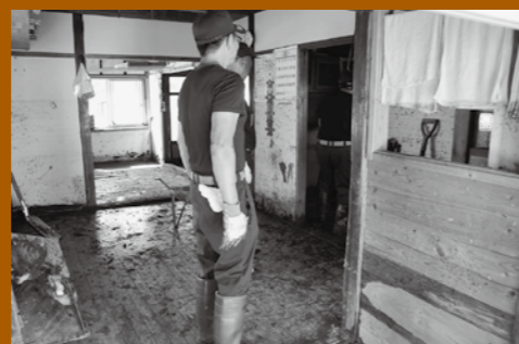
壁の半分以上が浸水していたと思われる住宅
