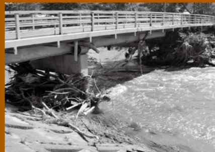
流木が突き抜け羅賀橋は橋脚1本がなくなった
