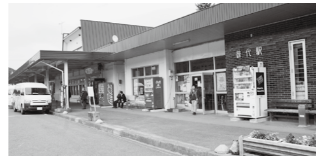
改修が行われる予定の普代駅舎
