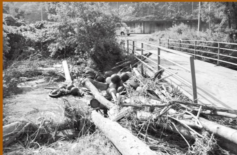
村民グラウンドへ行く鉄板橋にも大量の流木。グラウンド、テニスコートにも濁流が流れ込んだ
