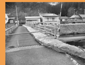
応急復旧された送配水管
