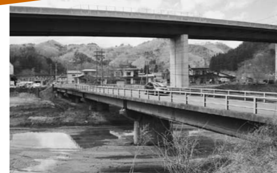
補強工事が行われる予定の普代橋
