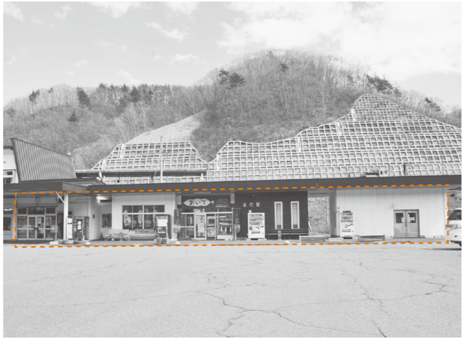
交付金の関係で改修工事（点線内）が延期となった普代駅舎
