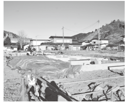
基礎部分が完成した南浜住宅(緑区)
