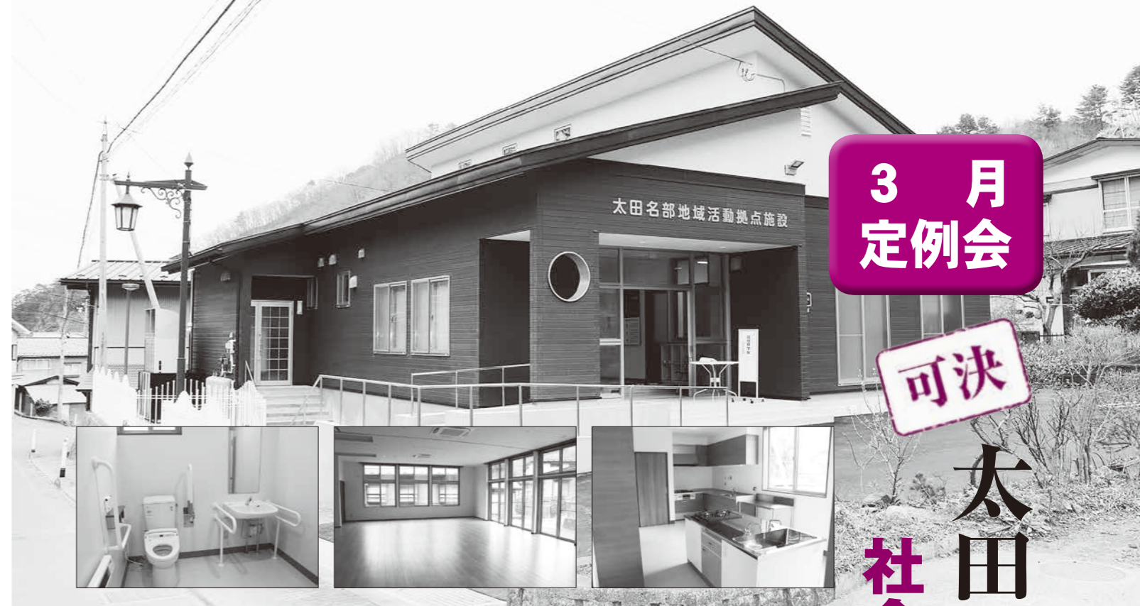
3月末、旧太田名部児童館跡地に完成した太田名部公民館。広いトイレときれいなホールも設備
