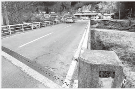
8月着工予定の普代橋補修補強工事
