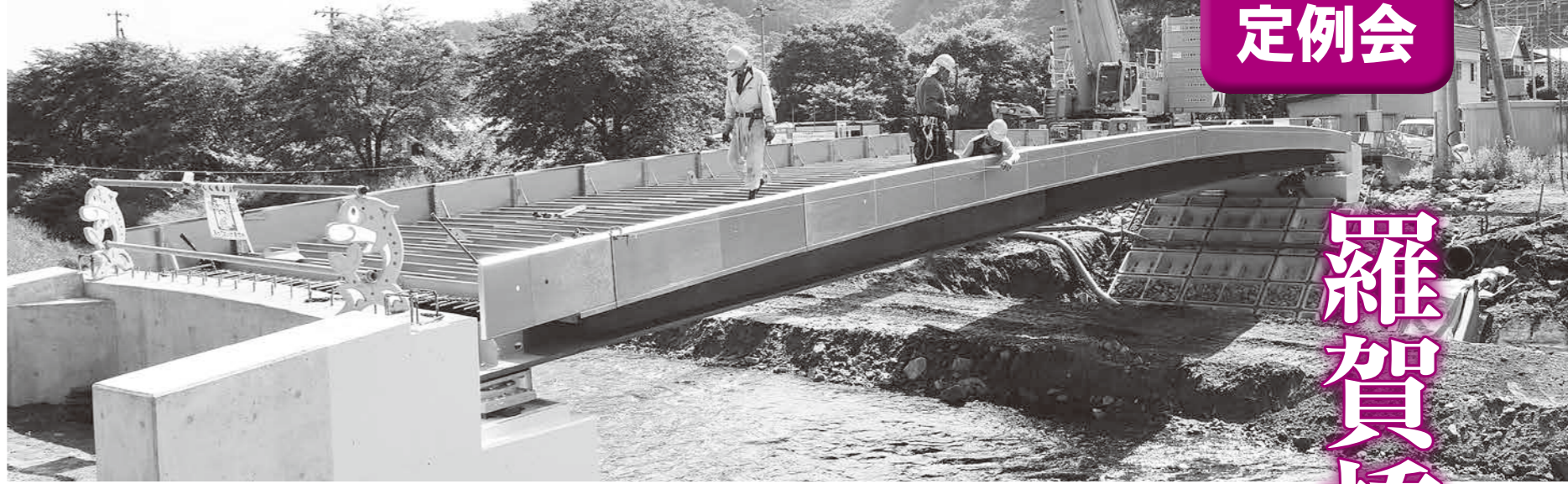
8月末完成予定の羅賀橋災害復旧工事 (7月14日現在)
