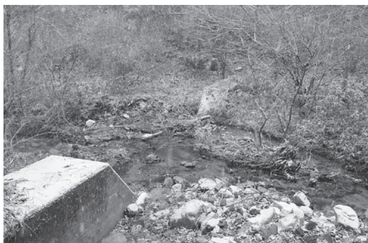
上区治山ダム
