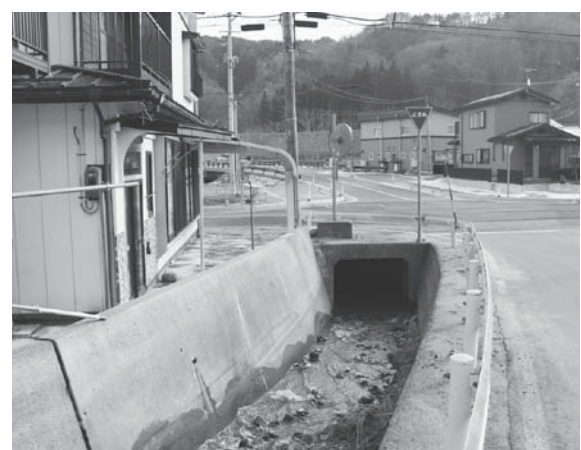
土砂撤去後。定期的な確認と撤去が必要となる
