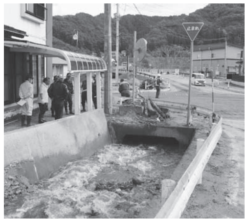
上区側溝。土砂の堆積で浅くなった河床
