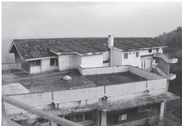
くろさき荘の食堂から見た解体予定の別館
