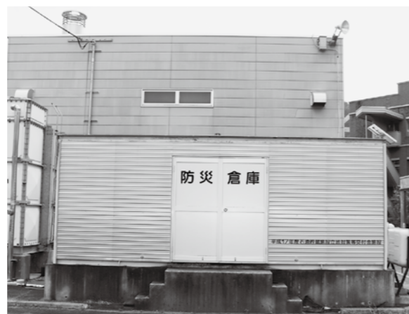
役場裏にある防災倉庫。村内のどこに備品を保管しているのか把握しておきたい
