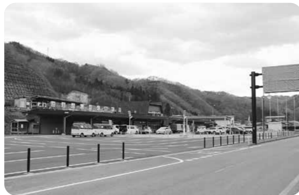
道の駅となった普代駅。着々と工事が進められている
