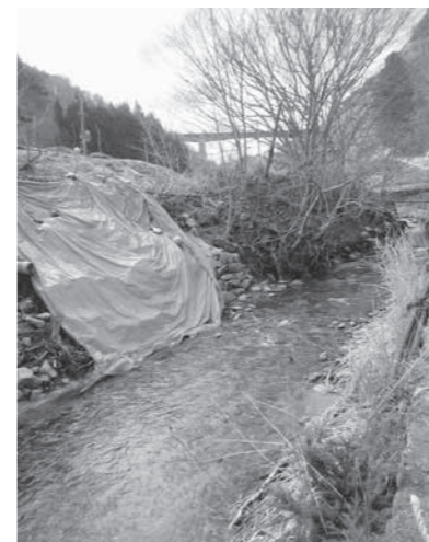
川底が削られ、のり面が崩れた状態
