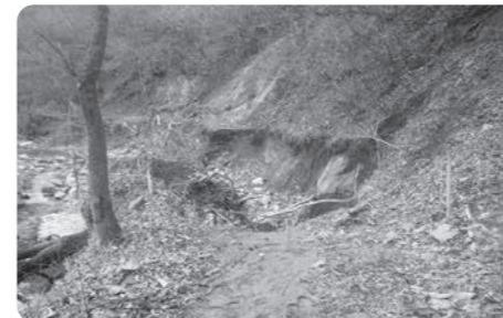
通行不能となった北沢線の道路
