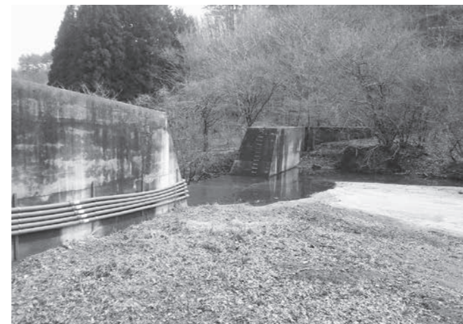
川底が削られるのを防ぎ、水の流れを遅くする不透過型砂防堰堤
